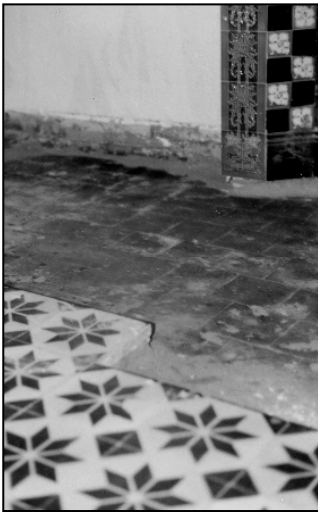
Fig. 2. originele zwarte vloer (ca. 1900), onder de 'sterrenvloer' (ca. 1930), en basis van de schoorsteen.
